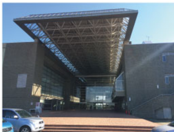
西側エントランス
